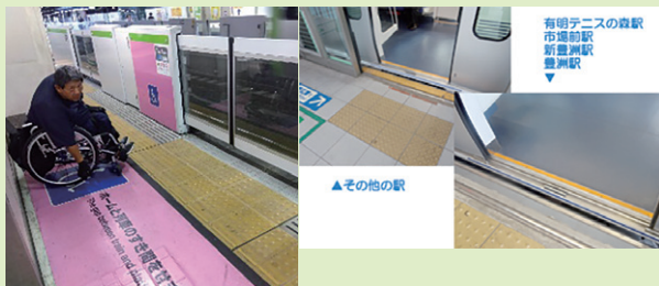
車いす等昇降場所は段差・隙間対応している表示を目立つように工夫!
