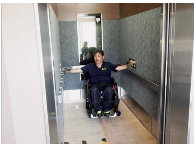
奥行きがあり、広々としたエレベーター
